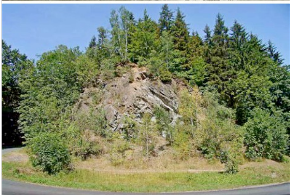
Pohled na odtěženou skalní ostrožnu Přívlastkové tvrze z konce 19. století (ještě před vybudováním železnice) a z dnešní doby.
