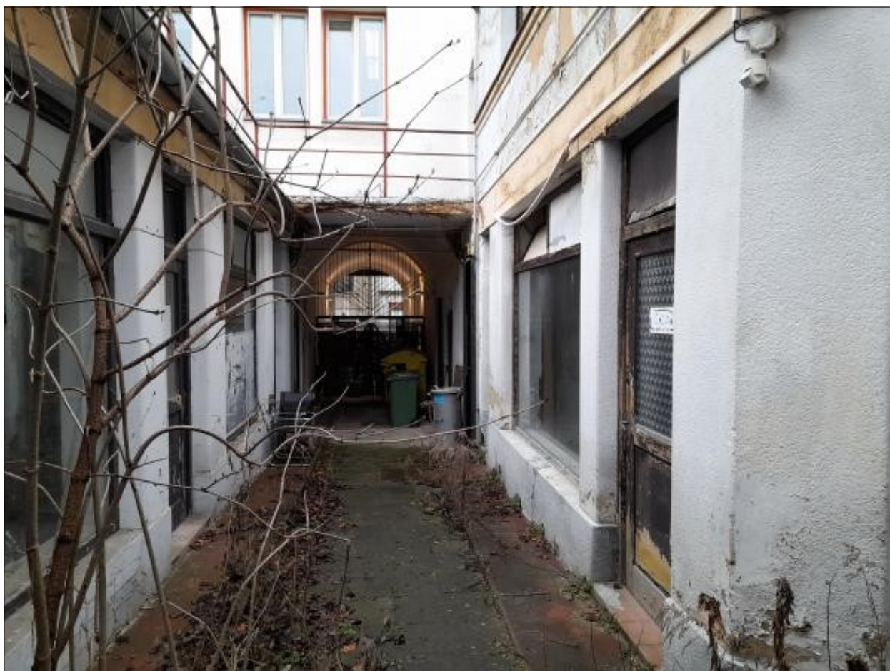
Stav před rekonstrukcí – níže poté
